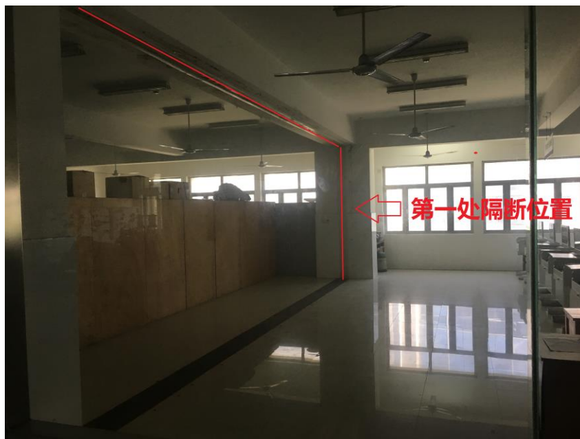
第一处隔断位置
